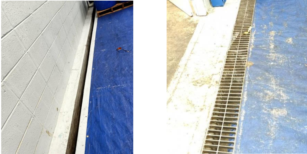
Hình 3.22. Rãnh chống tràn kho chất thải nguy hại
